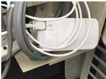
⑩通信回線の接続方法が工具無しで着脱出来る方式であること。 (写真は光回線用光コンセントの例)
