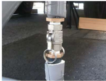
⑥給水管の接続方法が工具無しで着脱出来る方式であること。
