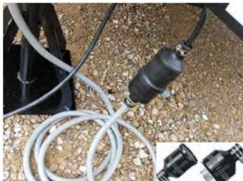
⑧電気配線の接続方法が工具無しで着脱出来る方式であること。
