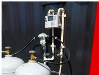
⑨ガスボンベがトレーラーハウスの積載されているかまたはレンチのみで簡単に着脱できること。
